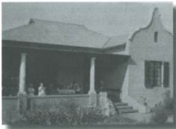
Die De Kock-woning in Meulstraat, Caledon.
